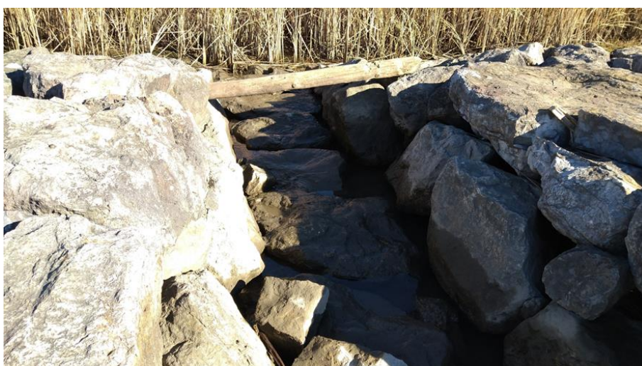
写真 2-10 下流の開口部（割石空積堰堤からワンドを望む）
