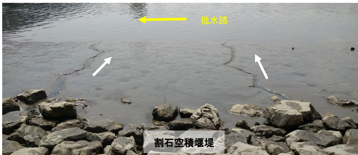
写真 2-11 割石空積堰堤を通過する水
