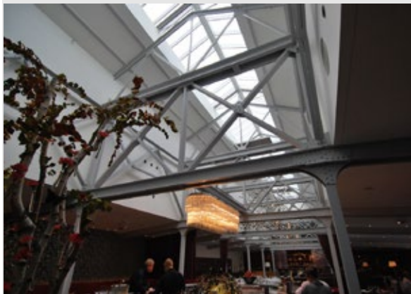
内観 2階レストランの天井見上げ。鉄骨トラスが屋根を支え、二階の床を吊る。
