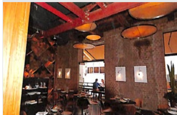
内観(4) 一階レストラン。レンガ壁が保存され、鉄骨の梁がかけられている。
