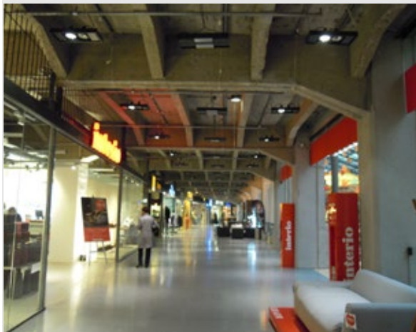
内観③ 旧工場棟に設けられた売り場の様子。構造体に設備機器が取り付けられ、露出している。
