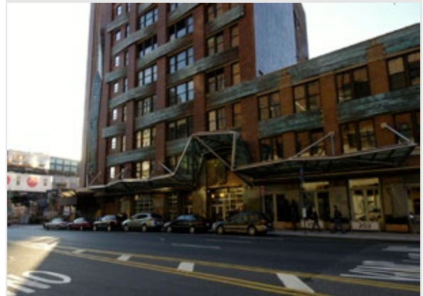
八番街に面するファサード 既存外壁の上に、金属とガラスの庇および曲線のパターンが付加された。
