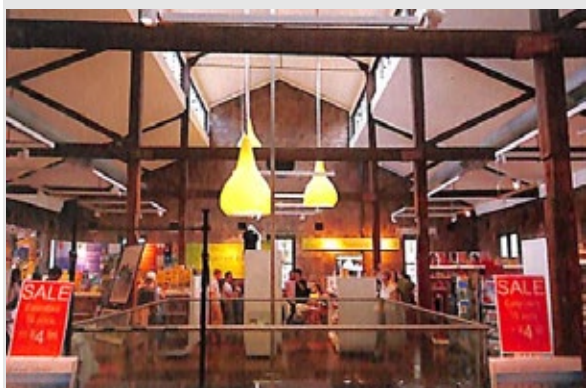
内観(2) 古材に対して鉄筋補強がされている。
