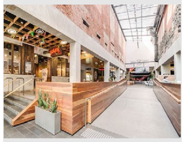
内観(1) 新設の柱梁で補強し、既存のレンガ壁を残している。新設されたレベルの異なる床には、スロープとステップで登ることができる。スロープ上部はトップライトと、既存のレンガ壁によって外の通りのような印象になっている。
