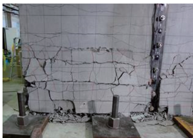
写真-5.5.2 荷重終了時における柱基部の状況
