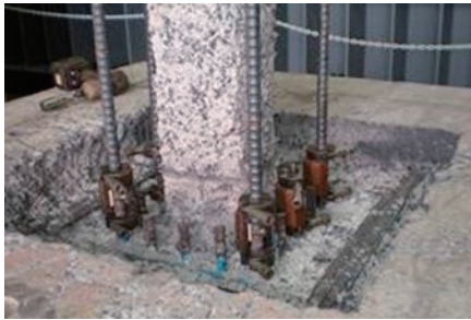
軸方向鉄筋セット
