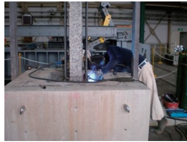
突合せアーク溶接状況
