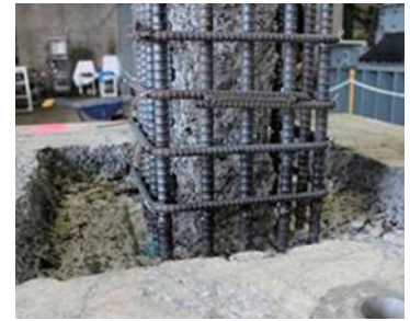
鉄筋組完了
