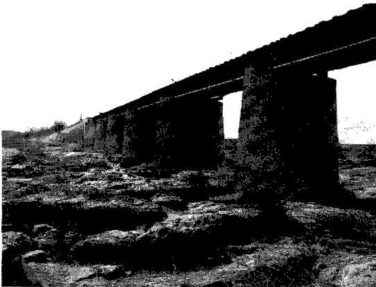
図34 図33に示した鉄道橋の近景
