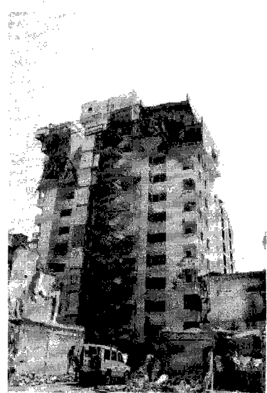
図17 Ahmedabad の10階建て建物の被害
