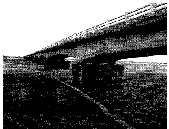
図36 Hadakiya Creek 橋の被害 (床版の波打ち)
