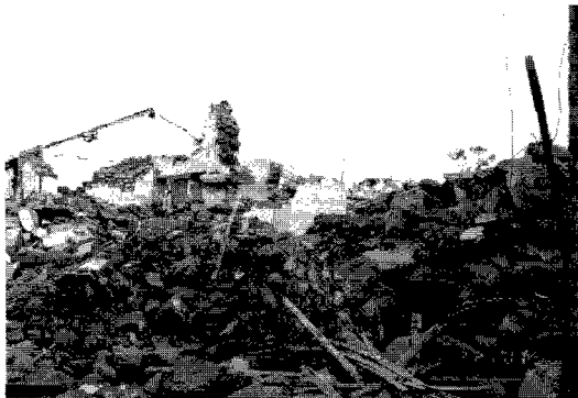
図20 震央付近の農村部のレンガまたは石積の家屋の被害(Kukmaの全壊跡)
