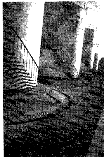
図58 Oil India のタンクの被害状況
