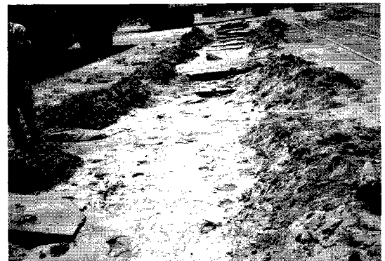
図69 Kandla 港内引込み線ヤードの液状化被害
