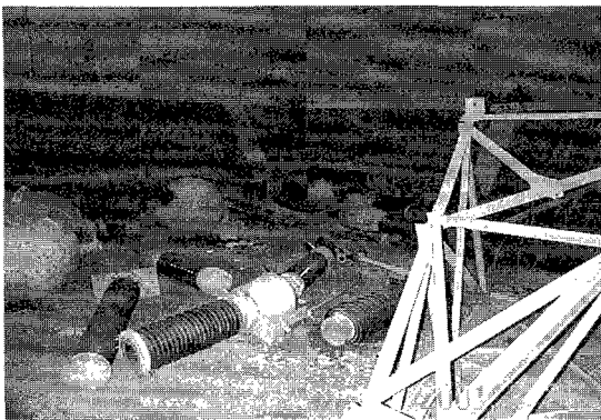
図54 変電機器の被害 (碍子、ブッシングの破損)
