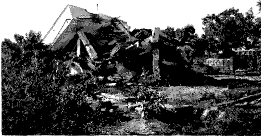
図24 震央付近のRC造建物の被害(Manfera)
