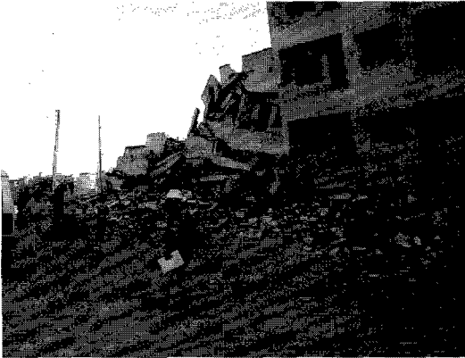
図23 震央付近のRC造建物の被害(Bhuji)
