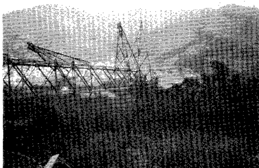
(a) 国姓の送電鉄塔（# 203）の倒壊
