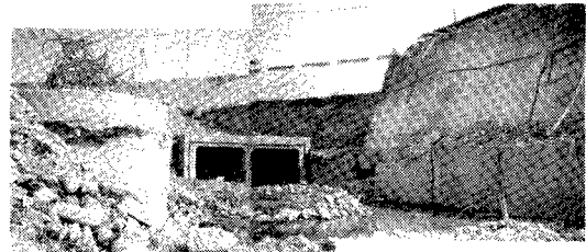
写真23 山岳トンネルの被害
