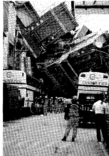
写真7 12階建の共同住宅。全部で4棟建っていたが将棋倒しに全部倒壊した。
