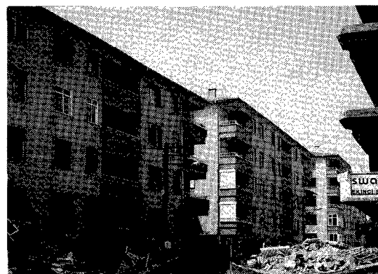
[ほぼ同一形状の建物3棟のうち、一番手前は2層分崩壊し、次は1層分崩壊したのに対して、一番向こうの建物は崩壊を免れた]
