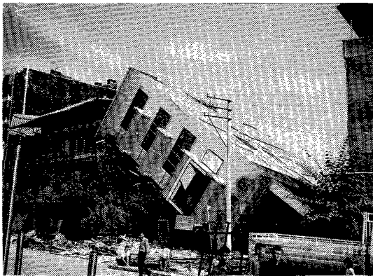
写真8 アダパザル市内の建物の転倒
