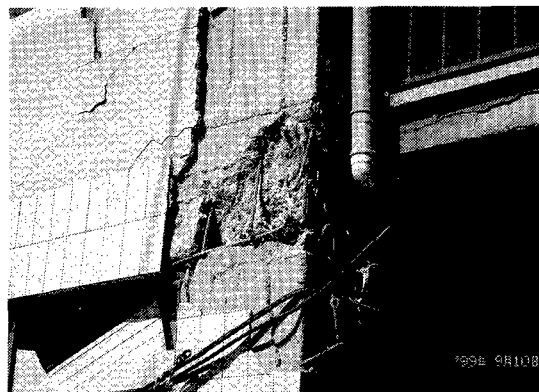
[梁主筋の定着位置が外側に寄り過ぎている]
