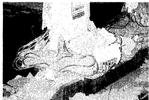
写真8 神戸高速鉄道大開駅地下2階の中柱の被害 (b)
