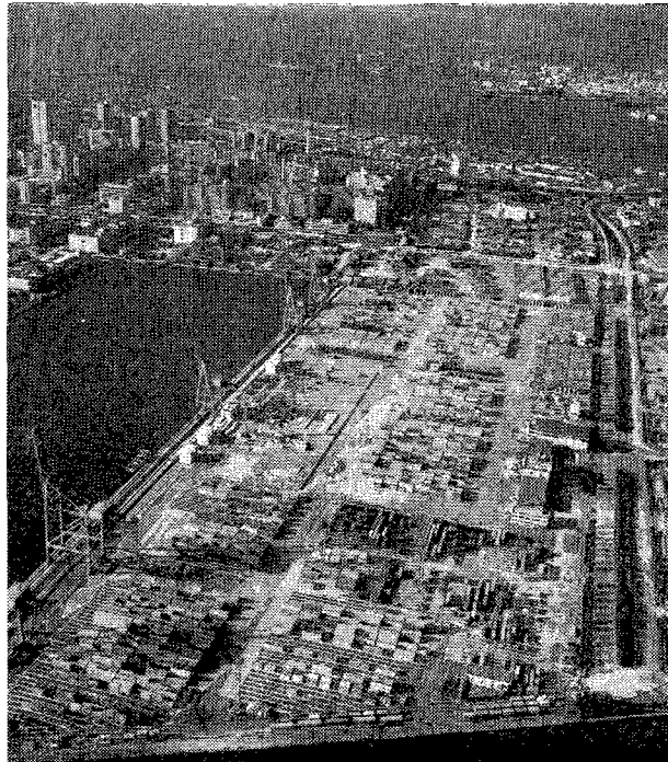
写真12 ポートアイランドの液状化による被害
