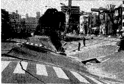
写真9 神戸高速鉄道大開駅地上部の陥没
