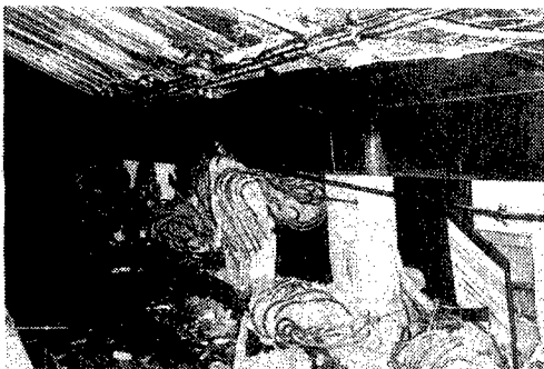
写真7 神戸高速鉄道大開駅地下2階の中柱の被害 (a)
