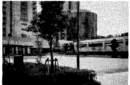
写真15 ポートアイランドの高層住宅(高層ビル)周辺地盤噴砂少なく、ビルに被害無し)
