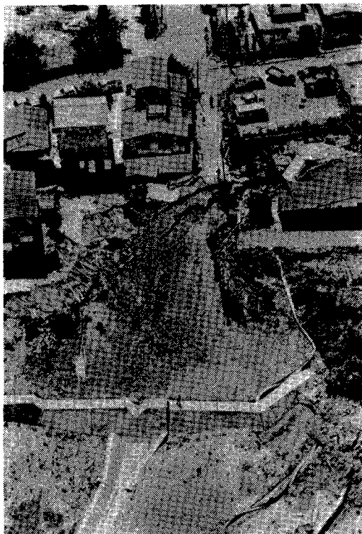
写真3 緑ヶ丘3丁目谷埋め盛土地の地すべり(河北新報社提供)
