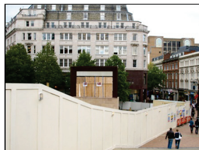
写真7 バーミンガム市ヴィクトリア広場に設置された大型スクリーン (騒音防止の覆いの設置工事中) (筆者撮影)
