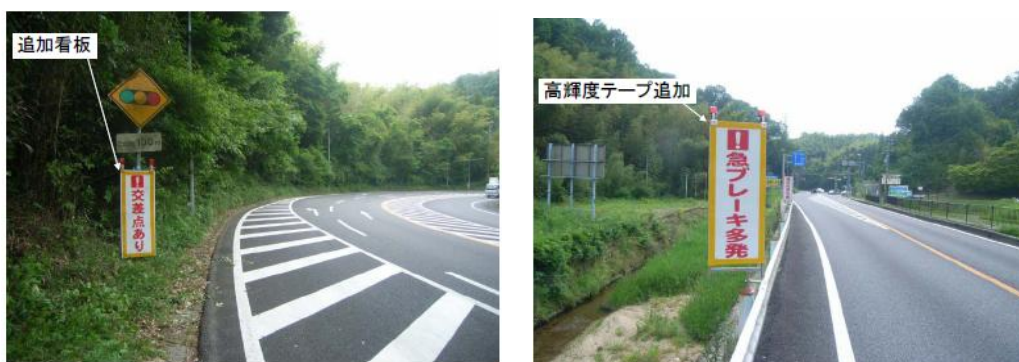
図 6-14 全反射テープを装着した道路標識（左：下り，右：上り）
