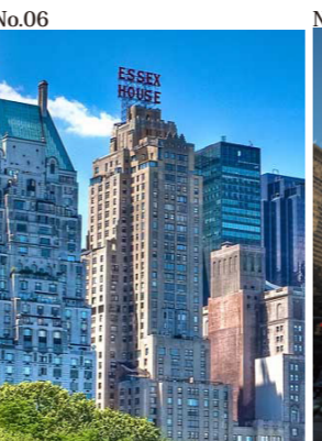
No.06 △: Marriott Essex House ミッドタウンウエスト ホテル→オフィスビル→集合住宅+テナント built 1931/open 2012 511室
