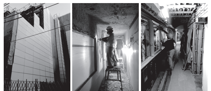
図11 事例⑤における施工現場の様子
