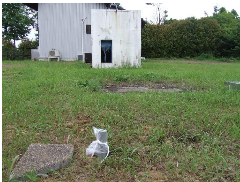
写真 3.14 設置後の様子
