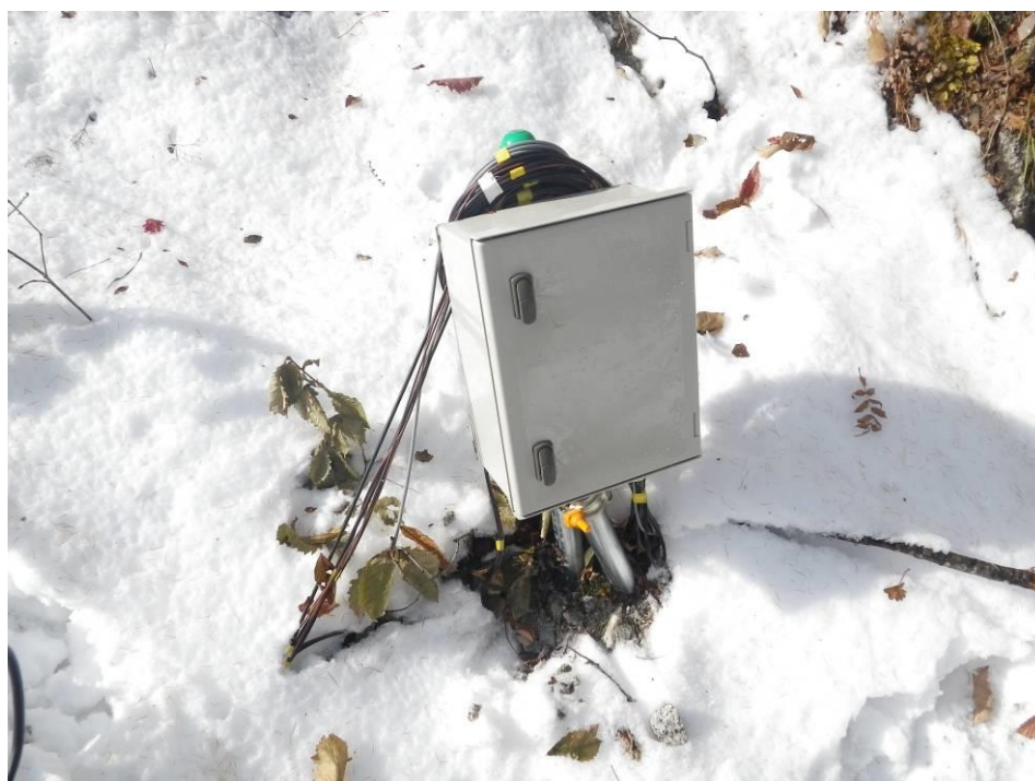
写真 2.28 設置後の様子
