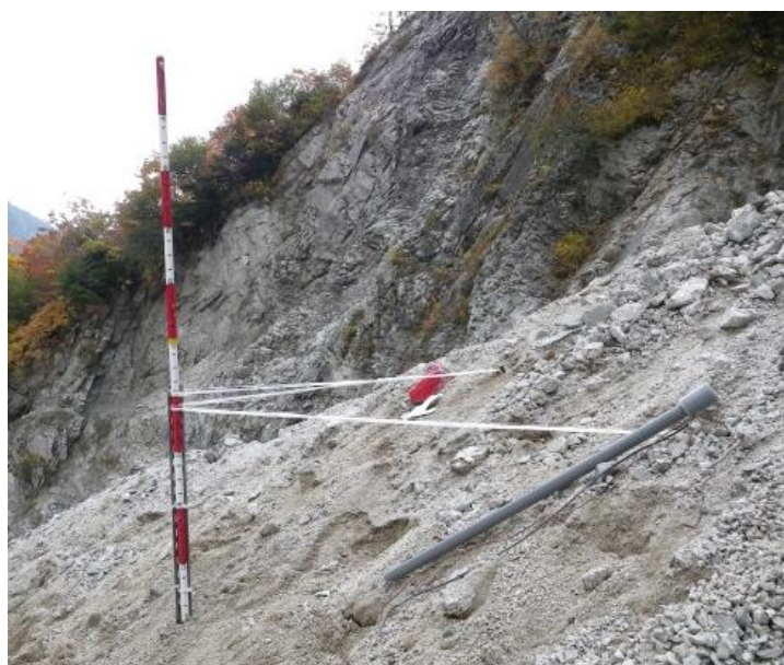
写真 2.31 観測ポール設置後
