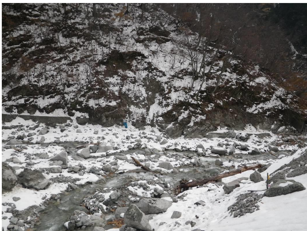
写真 2.44 上流側斜面撮影点 1(人が写っている地点)
