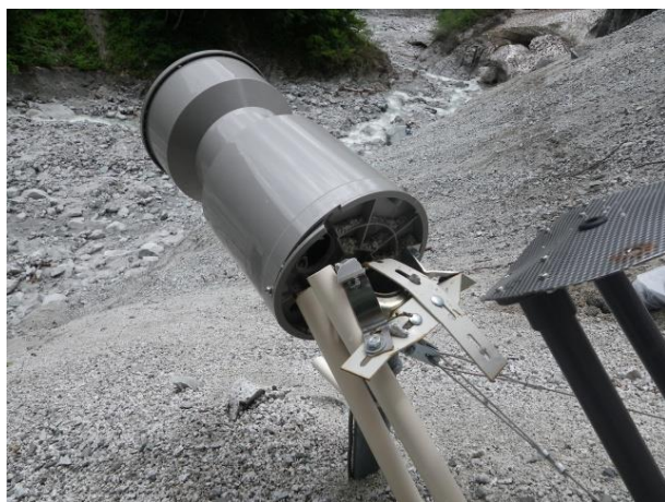
写真 2.38 傾いた雨量計
