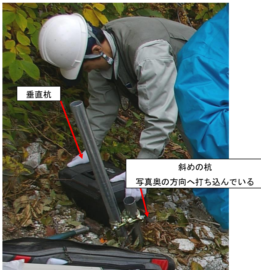
写真 2.26 杭の打ち込み
