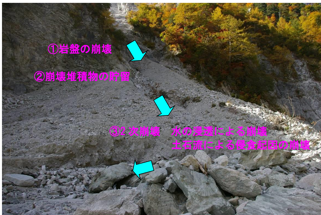
写真 2.2 計器設置地点の崖錘部と崩壊プロセス
