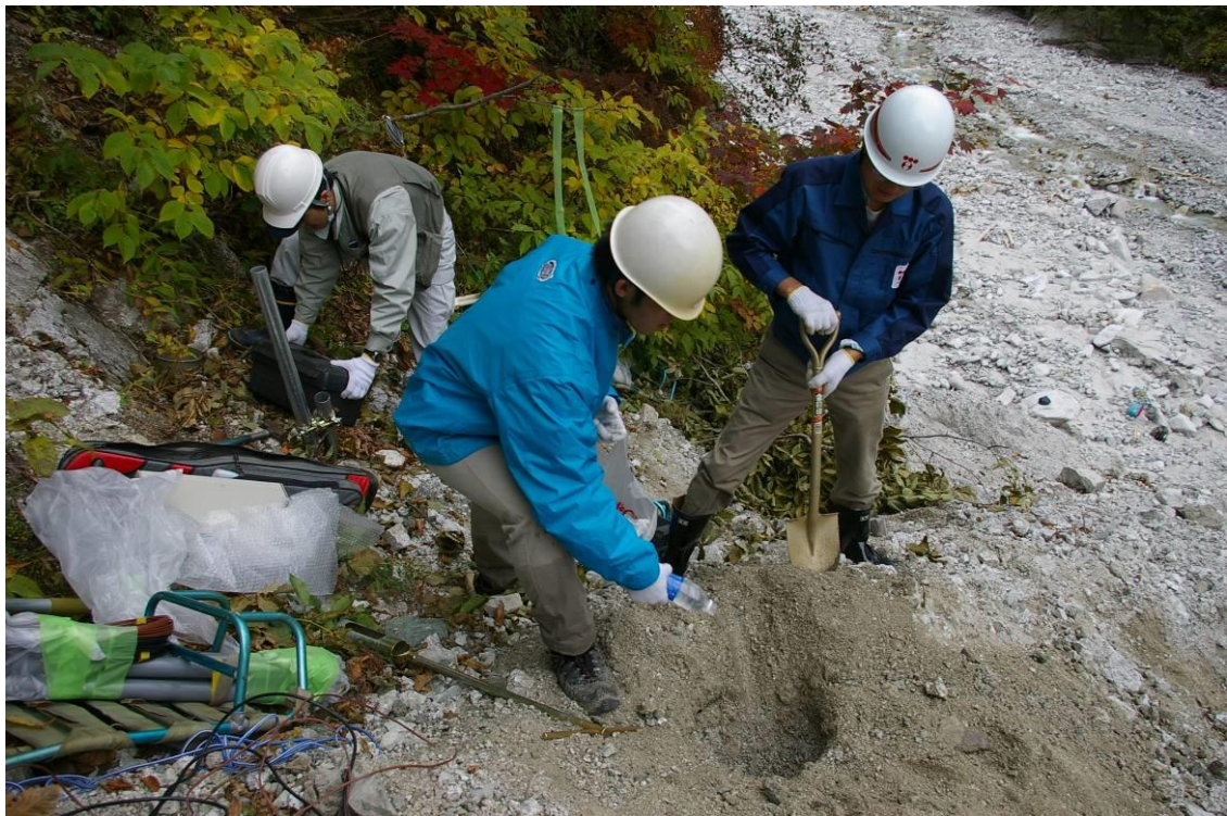
写真 2.15 穴に水を撒いて自立させている様子
