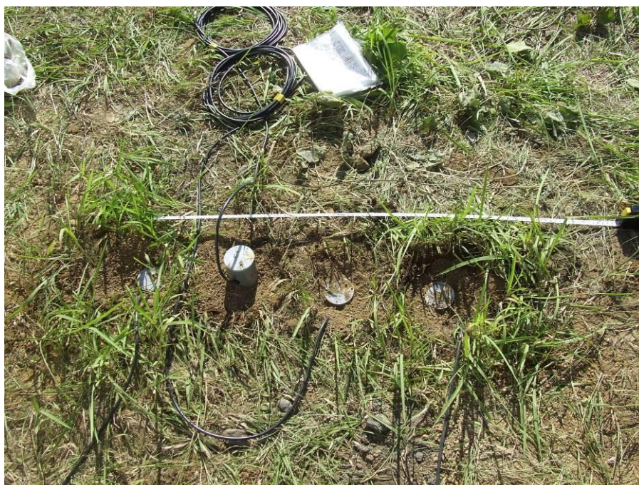
写真 3.6 埋設後の状況
