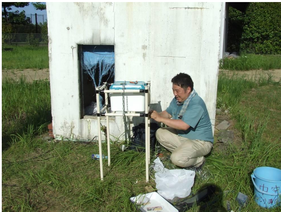
写真 3.11 収納箱設置後
