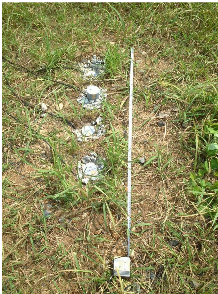
写真 3.7 ベントナイトを敷いた後の様子
