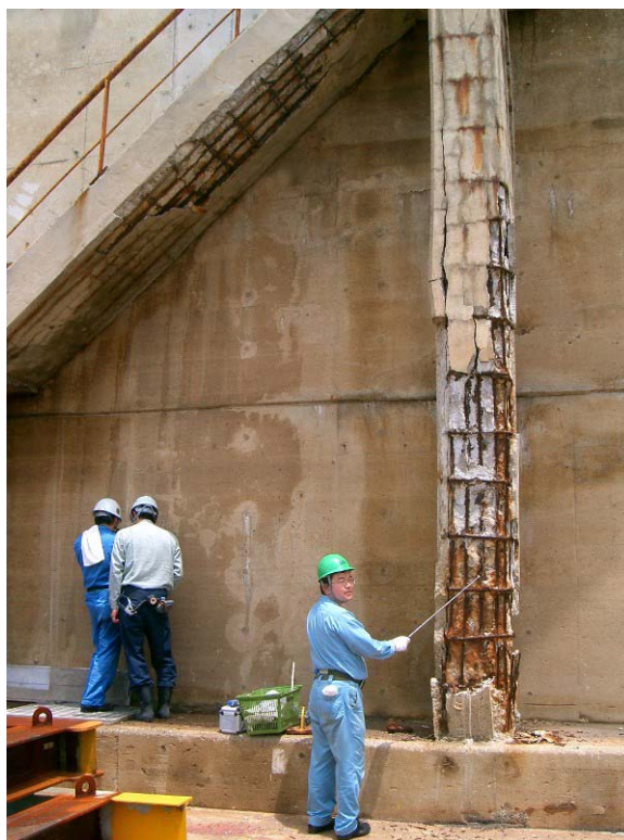
図 4.2.5 塩害により劣化したコンクリート柱
