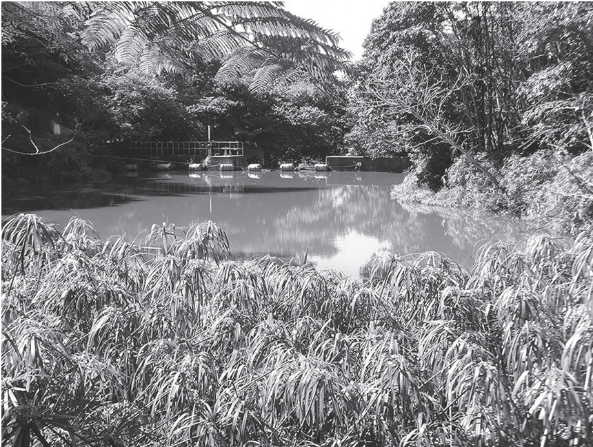
図 1 長谷ダム（上流側より堤体を望む）
