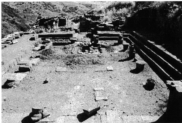
左(3-1) 会堂奥(北東方向)より正面入口(南西方向)を望む。
