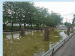
旧相模川橋脚
