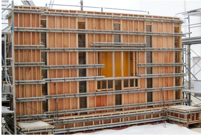
写真 4.1 模擬柱壁試験体の型枠状況
