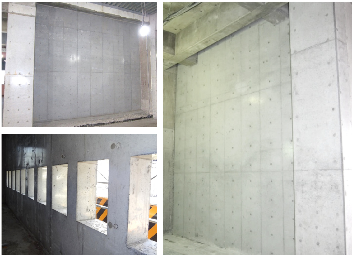
脱型後（増打ち壁，増打ち柱，開口部を有する壁）
