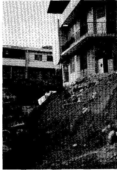
写真1 車籠埔断層の断層運動にともなう上下ズレと建物の被害（大坑）
