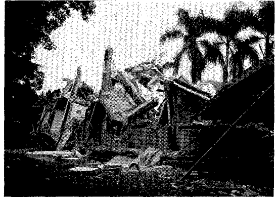
写真13 光復国民中学校の3階建の校舎が完全に倒壊した状況（霧峰）
