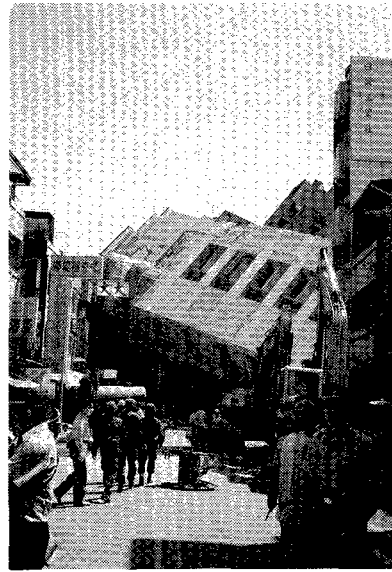
写真5 14階建マンションの倒壊状況（東勢）
