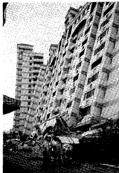
写真15 14階建マンションの倒壊状況（太平市）
