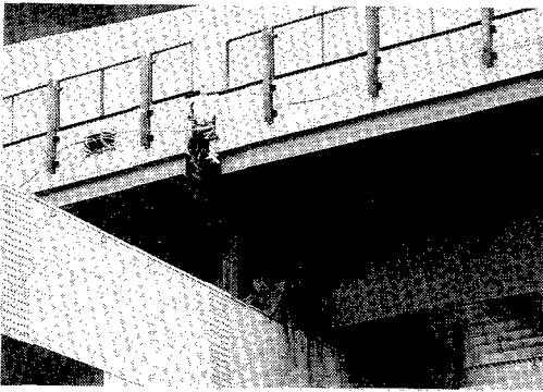
写真7 耐震連結装置（タイプ1）の被災例とその効果
