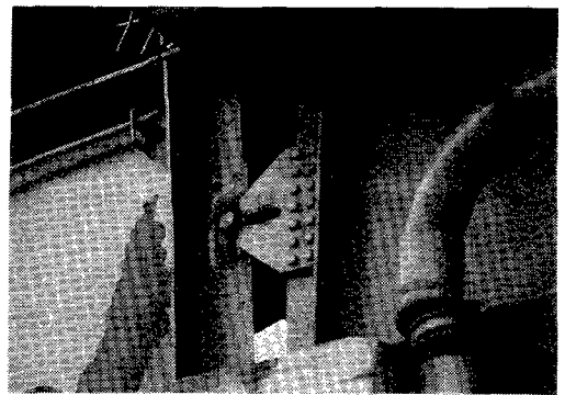
写真6 耐震連結装置（タイプ2）の被災例とその効果
