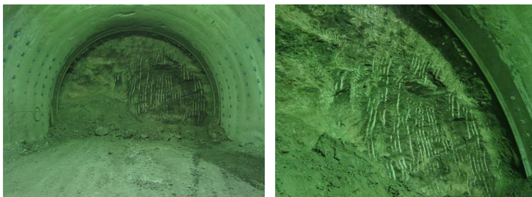
写真 1.1 曲面切羽試験施工の様子（中部横断自動車道 八之尻トンネル）
