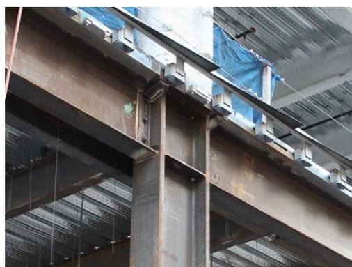
図 1.2 H形鋼柱接合部
