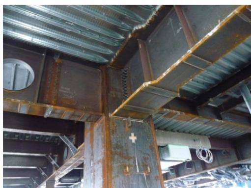
図 1.1 角形鋼管柱接合部
