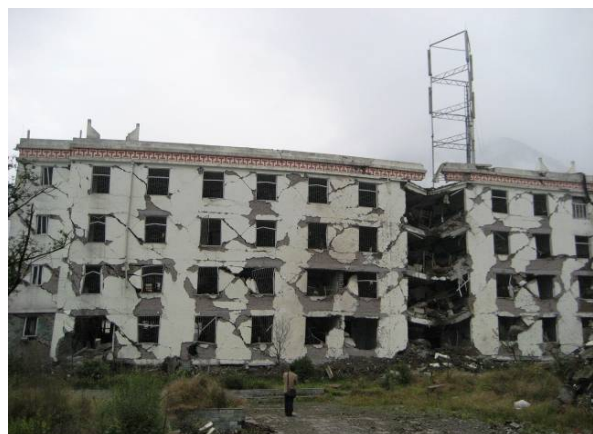
写真1.1 四川大地震による被害 1階が完全に崩壊した5階建ての学生寮
